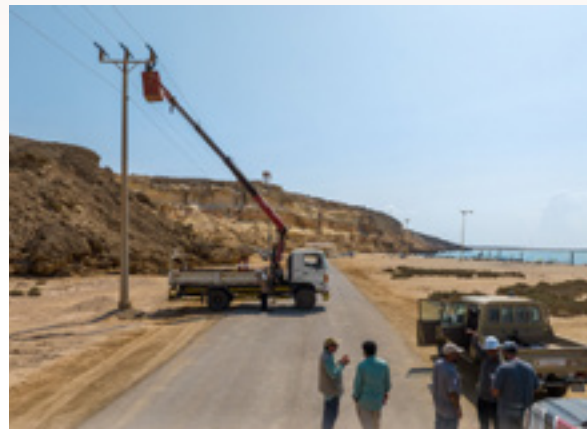
صور لتركيب عوازل الكهرباء ذات الجهد المتوسط في جزر فرسان
